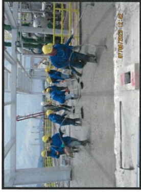
Pouring concrete slab level +32.50 m. MP6.
