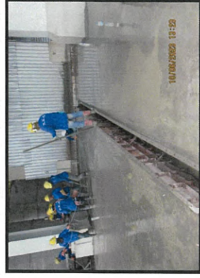
Pouring concrete slab level +0.25 m. MP6.
