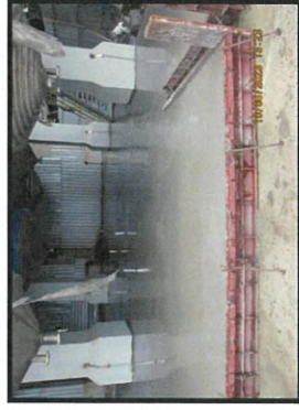
Pouring concrete slab level +0.25 m. MP6.
