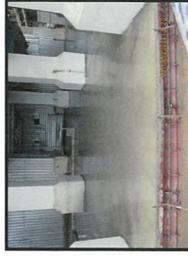
Pouring concrete slab level +0.25 m. MP6.
